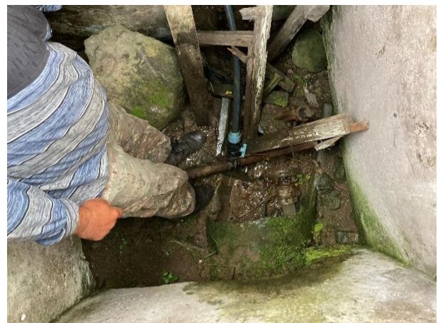
本件で整備した点検用マンホール内部
