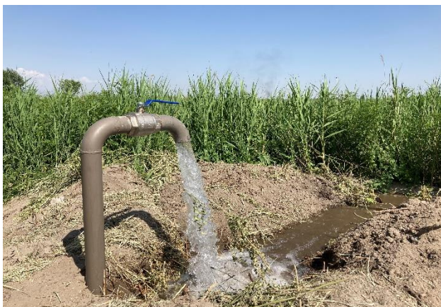
灌漑システムの放水口
