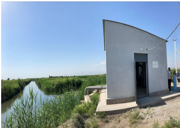
新設されたポンプステーション
