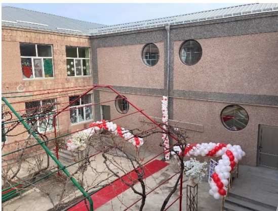
全面改修された校舎
