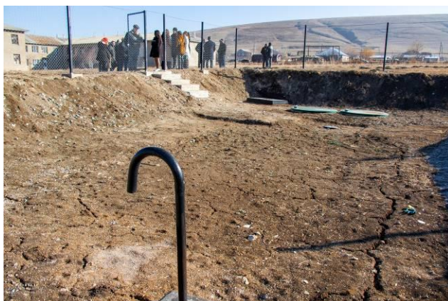
整備された下水設備
