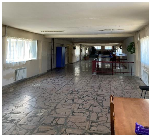
本案件で改修工事が行われる同センター内廊下部分
