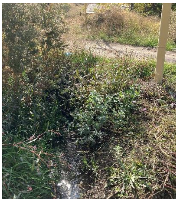
保護のない既存の排水溝
