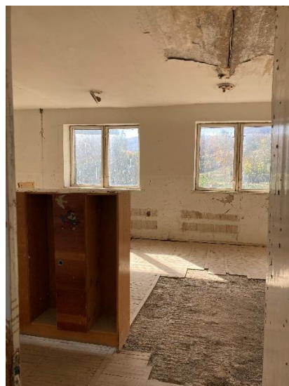
現在閉鎖中で改修対象となる一室
