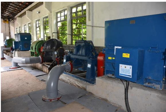
整備したポンプ設備
