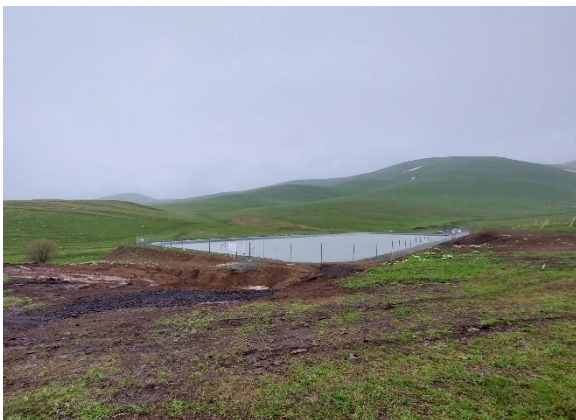
建設された貯水池
