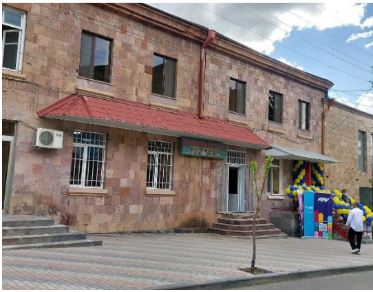
改修されたユースセンター
